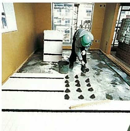
4 セメントモルタルをダンゴ状に並べる。
