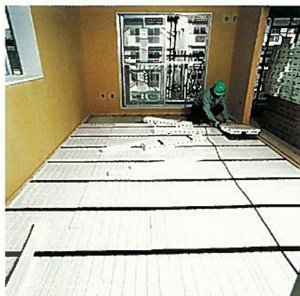
2 ネダマットFLを部屋の大きさ、床の配管などに合わせて切断加工する。
