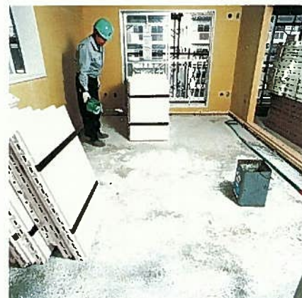
3 床スラブ面に接着剤ネダマットボンドAの希釈液を散布し、ネダマットFLの裏面にネダマットボンドAを原液のまま塗りつける。
