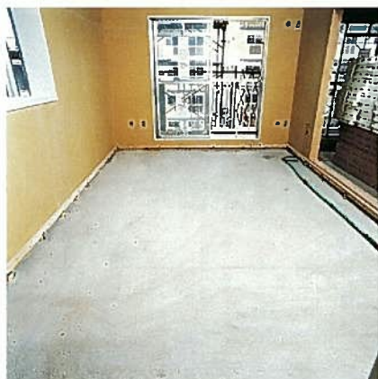
1 際根太を取付けてある施工前の部屋。
