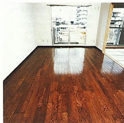
6 床仕上げ材施工。
