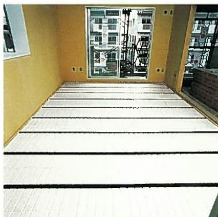
5 敷き込み完了 部屋は施錠してモルタルの硬化を待つ。(1日~2日)
